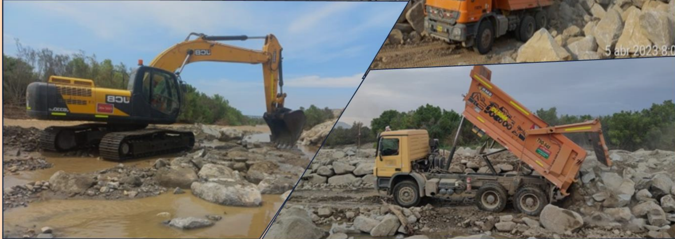
COLOCACIÓN DE ROCA EN UÑA
